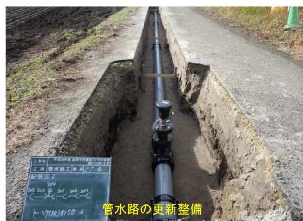
石綿管の漏水状況
