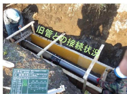
漏水補修工事
