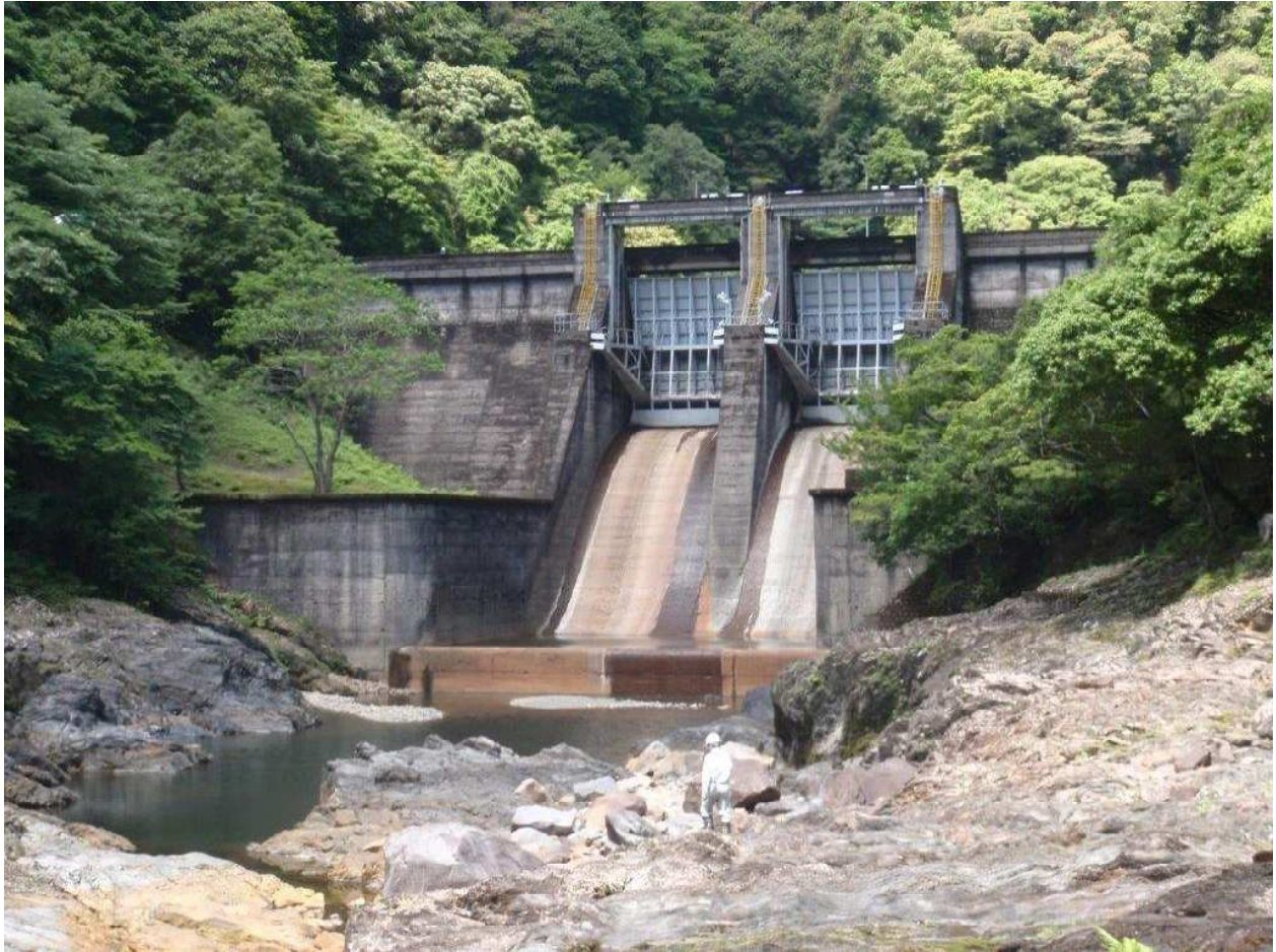
古賀根橋ダム
