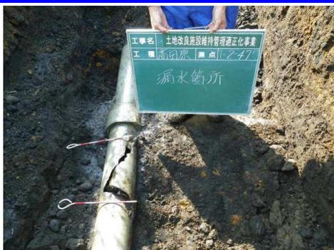
【石綿管の破裂状況】
