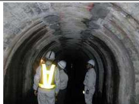
導水路内面調査
