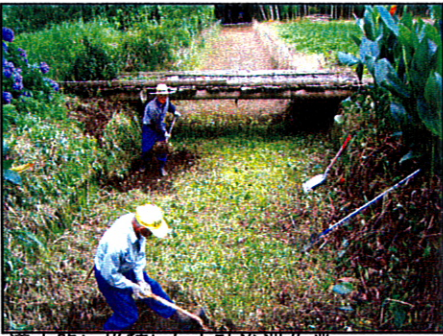
導水路に堆積した土砂浚渫作業
